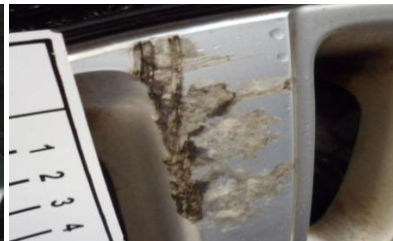
Schade als gevolg van oxidatie Niet acceptabel
