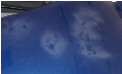
Schade als gevolg van reinigen met "schuurspons" Niet acceptabel
